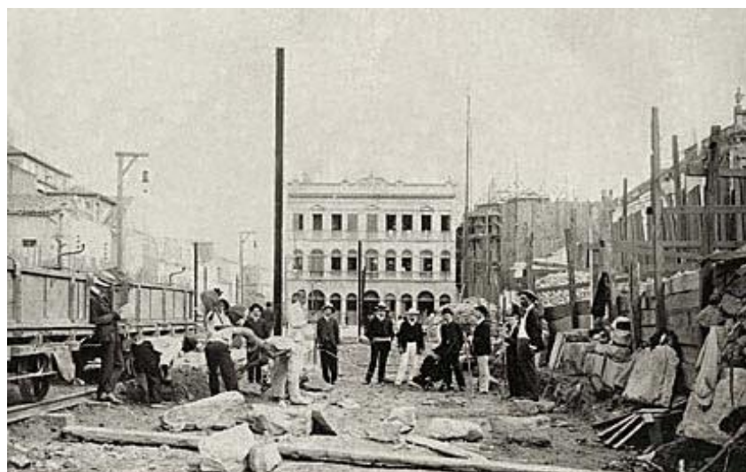
Demolições para a construção da avenida Central, 1904-1905 João Martins Torres – Acervo Instituto Moreira Salles
